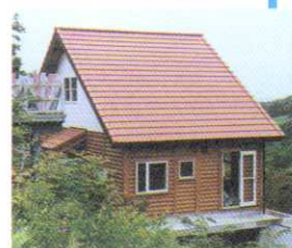
社内に建設中の ログハウス
